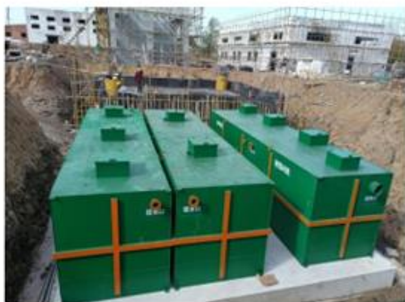
Dự án lắp đặt xử lý nước thải tại bệnh viện ( 医院废水安装项目)
