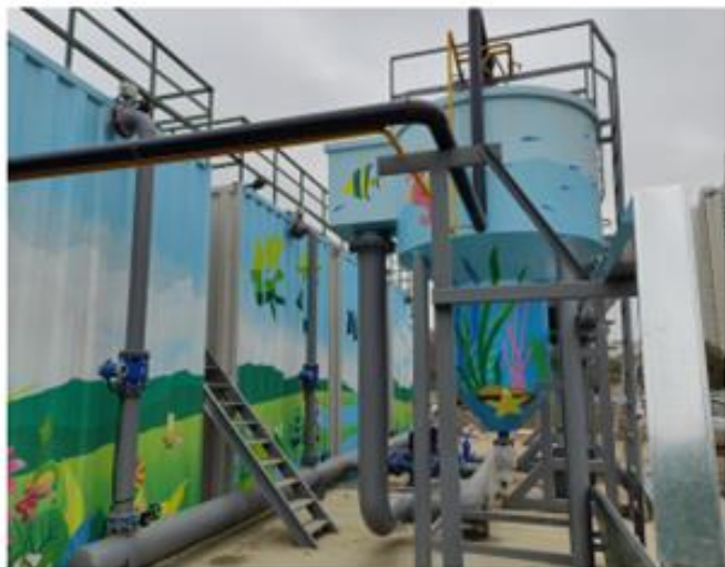
Dự án lắp đặt hệ thống xử lý nước thải tại tỉnh Hồ Bắc ( 湖北某地污水处理安装项目)
